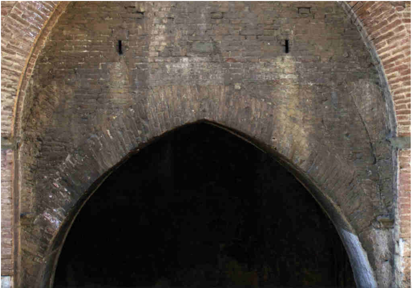
le tracce dei preesistenti archi visibili al di sotto dei nuovi
