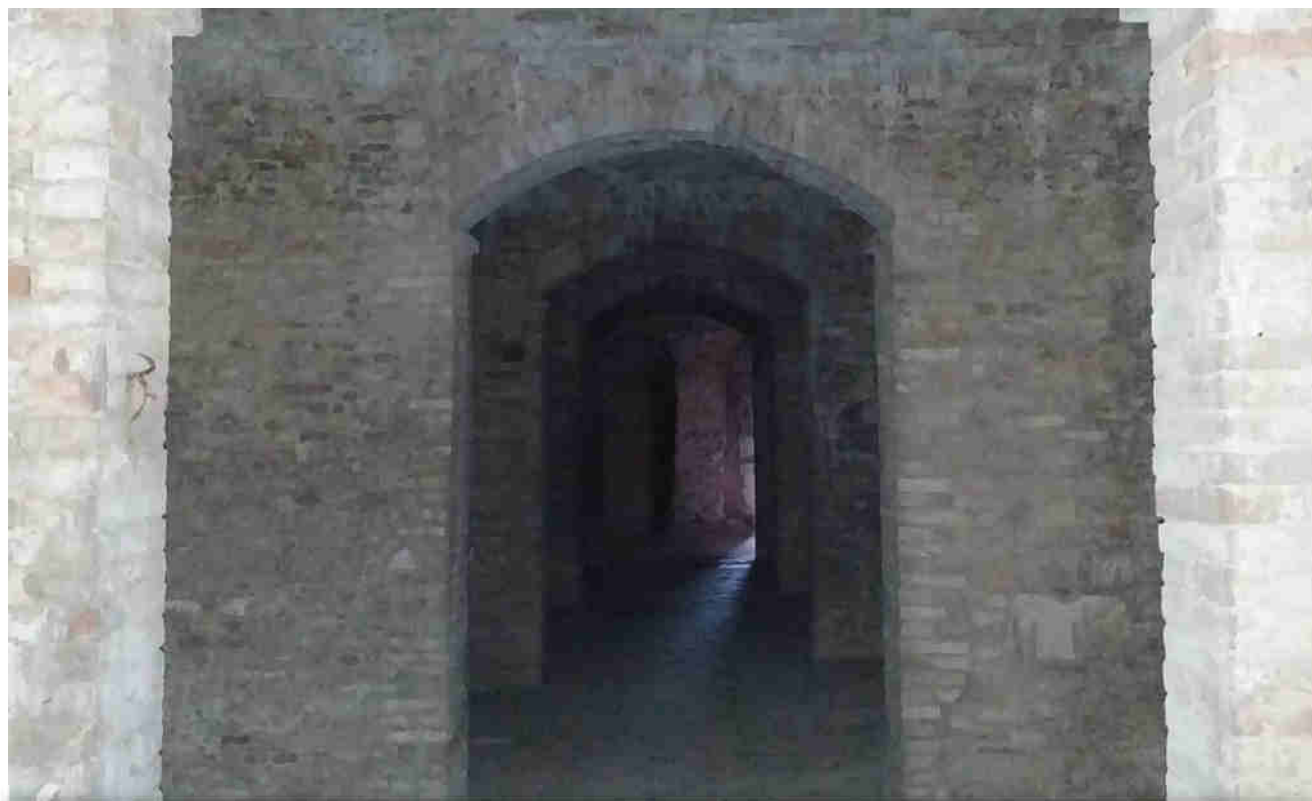
il piano intermedio dopo i lavori del 1919
