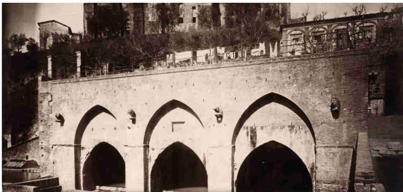
la fonte alla fine dell'800. Sulla destra si nota la struttura in legno posta a protezione della statua di santa Caterina
